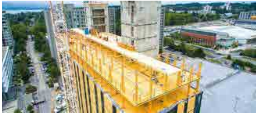
Vue sur la structure hybride bois/béton et détails des dalles de plancher en bois lamellé-croisé, piliers en bois lamellé-collé et raccords acier
