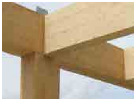
Exemple de raccord bois réalisé par machine à commande numérique © American Wood Council
