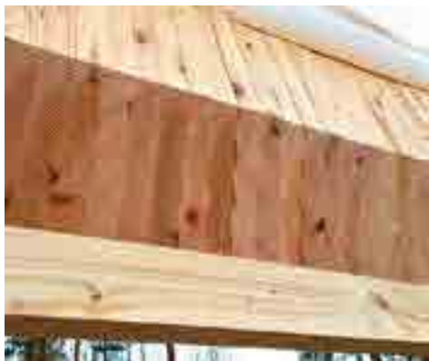
Structure en bois ondulé © Wood in construction
