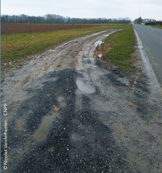
Accès sécurisé pour le chargement de betteraves.
