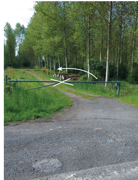
Situation actuelle dangereuse. Après travaux, la barrière a été reculée de 25 m de la route.
